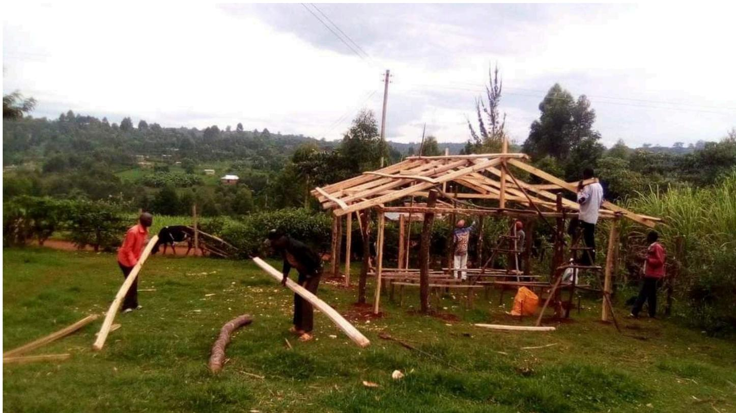
**Служба коммуникации ОВЦС, 08.11.2023.** В селении Сиксикет в Кении (округ Нанди) началось строительство деревянного храма во имя святого праведного Иоанна Русского. Уже возведен деревянный каркас здания; также подготовлена и установлена стропильная система кровли.
