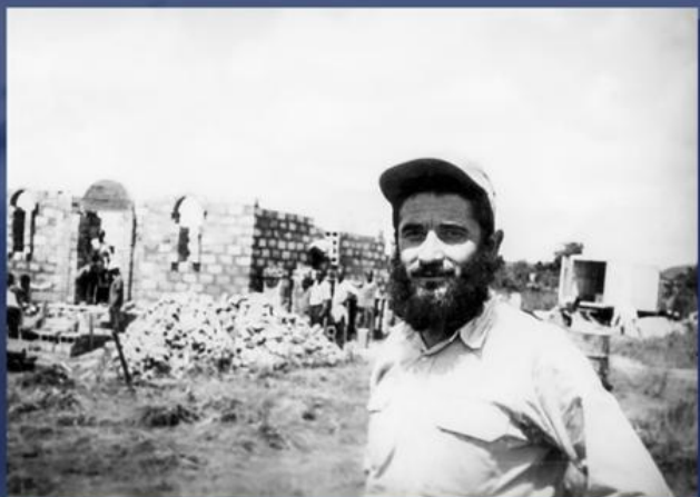
Иоанн Асланидис на строительстве храма
