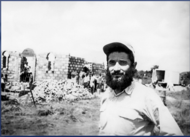
Ioann Aslanidis pendant la construction d'une église
